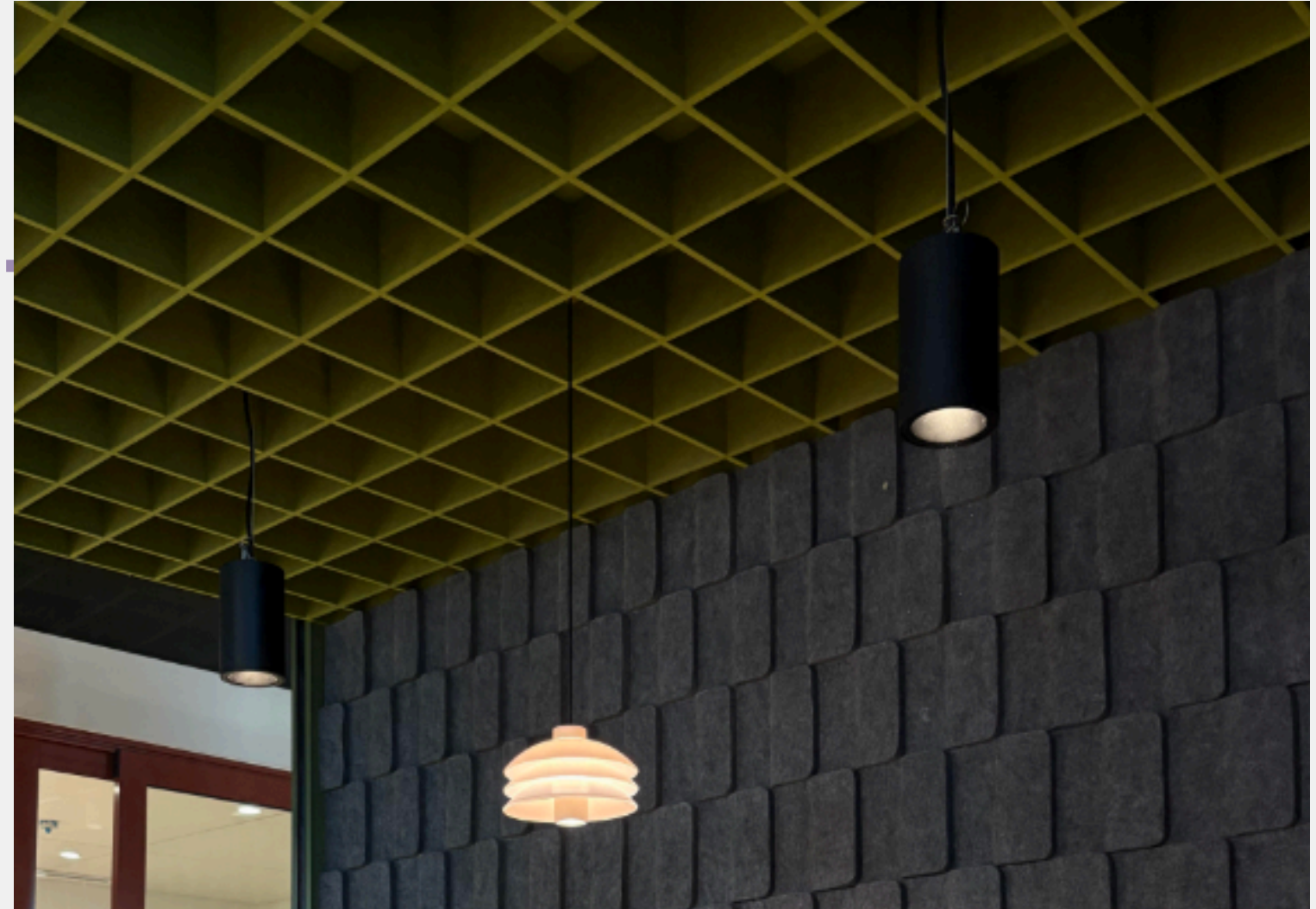
REJILLA EN PLAFÓN
